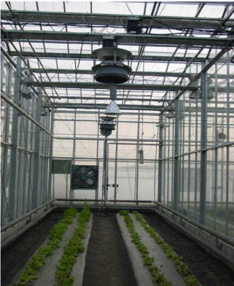
그림 1. 환풍장치를 이용한 공기 교반
