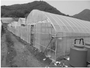
하우스 설치 완료
