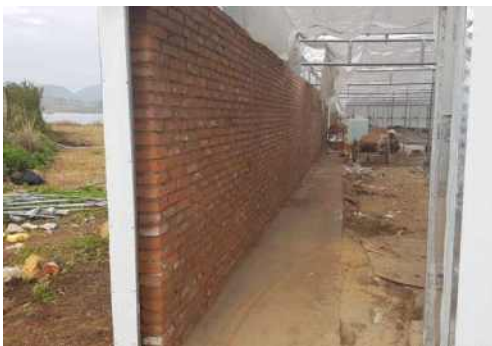
【 비닐하우스 측면 축열벽 설치 】
