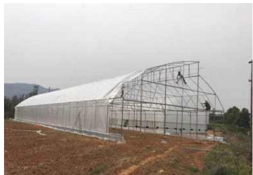
【 비닐하우스 피복 설치 】
